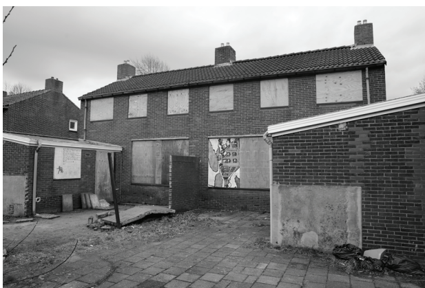
De inmiddels gesloopte woningen aan de Niesoordlaan.
